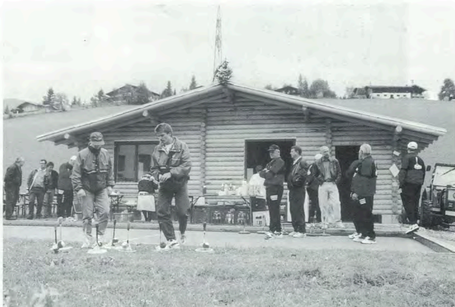
Obwohl noch nicht ganz fertig, hat sich das Eisschützen-Vereinsheim bereits bewährt.
